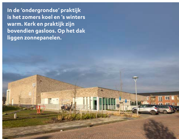
Een lichtschacht om het gebouw heen zorgt voor daglicht in de praktijk
